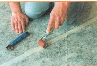
Lepící pásku jednoduše prořízneme ve švu krytiny kotoučovým nožem (Art. Nr. 50010); případně s nožem s rovnou čepelí.
